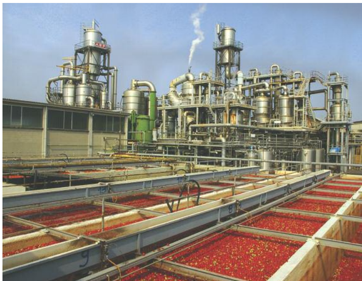
Anni '80. L'impianto di concentrazione capace di lavorare oltre 1 milione di quintali di pomodoro in una stagione.
